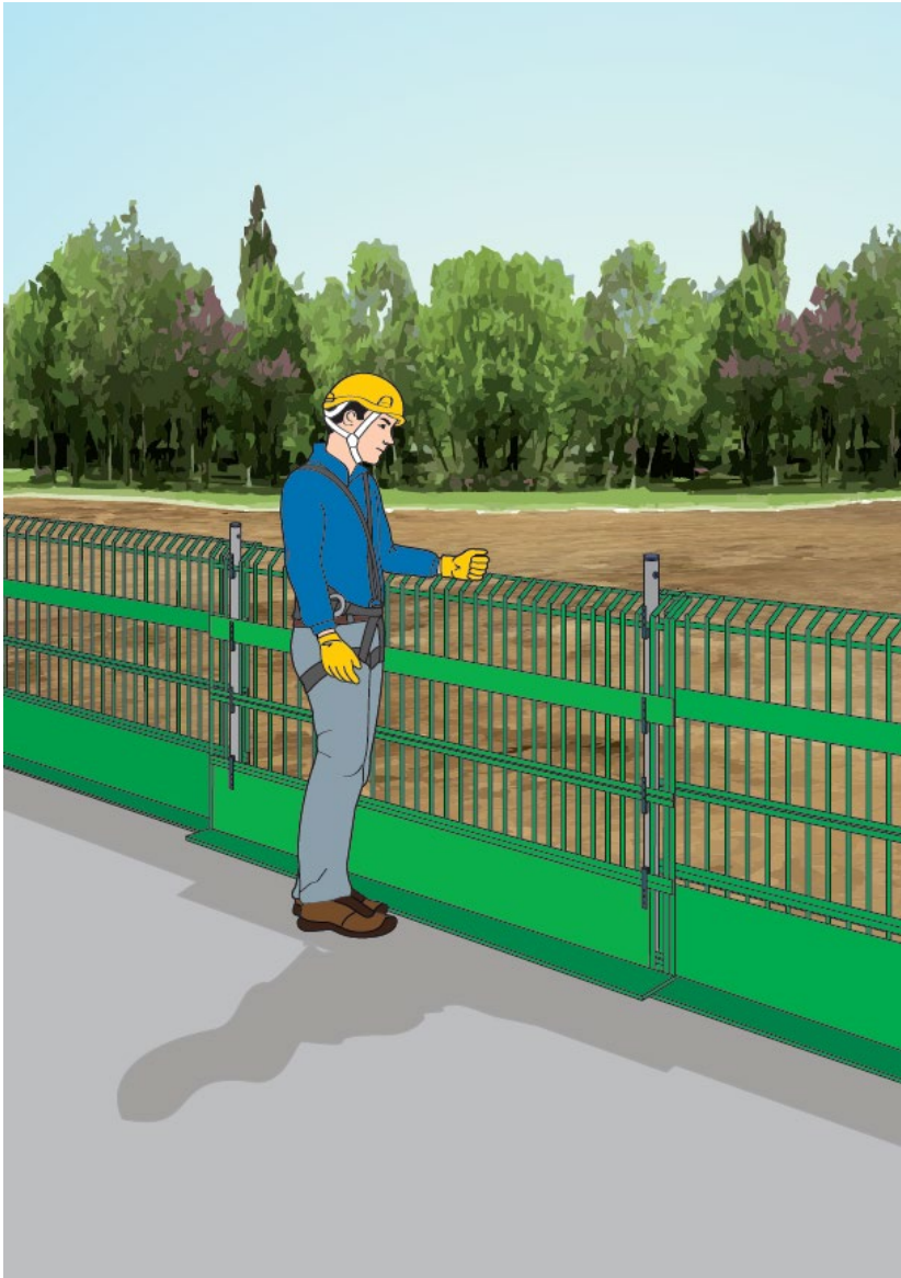
Figura 2 - Parapetto anticaduta provvisorio costituito da un pannello
