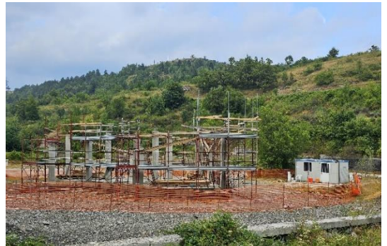
Figura 1. Un edificio in costruzione
