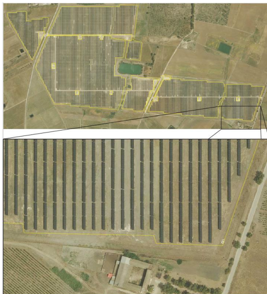
Figura 30. Esempio di impianto fotovoltaico a bassa densità (circa 110 ettari; codice 205), comune di Mazara del Vallo (Trapani). Le informazioni fornite dalla ditta installatrice riportano un'altezza dei moduli inseguitori da terra, in posizione orizzontale degli stessi, di circa 2,6 metri e una distanza tra le file (considerando il piede delle strutture di supporto) di circa 12 metri. Questa distanza si riduce a circa 9,6 metri considerando l'ingombro dei moduli completamente inclinati e a 7,4 metri con i moduli orizzontali
