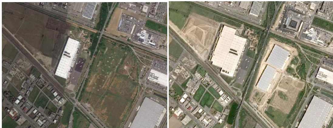
Figura 18. Cantieri e nuove costruzioni nel comune di Piacenza (immagini 2021, a sinistra, e 2022, a destra)
