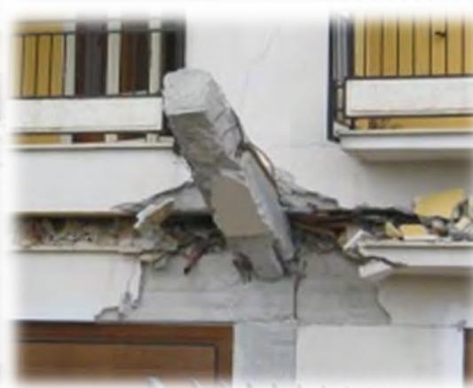
**Collasso strutturale** con espulsione esterna dei pilastri in c.a. e schiacciamento del piano primo da parte dei piani sovrastanti per il cedimento del nodo pilastro-trave non adeguatamente armato.
