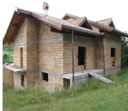
Edificio al grezzo in muratura portante
