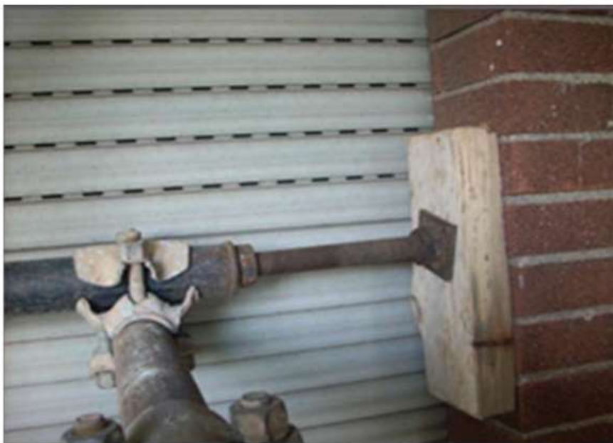
Fig. 4.4.15: Ancoraggio a vitone realizzato con asta estensibile a contrasto tra le spallette di una finestra.
