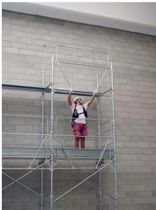
Monto un piano ed il parapetto superiore
