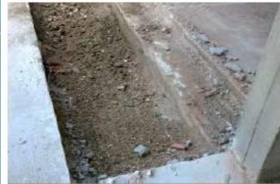
SCAVO A SEZIONE OBBLIGATA PER REALIZZAZIONE NUOVO SETTO IN C.A. S2, FRONTE OVEST
