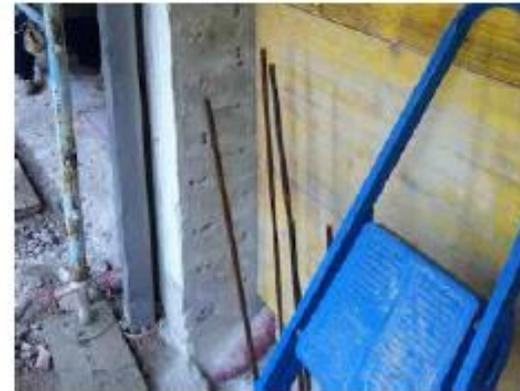
REALIZZAZIONE DI ANCORAGGIO E POSA DELL'ARMATURA PER L'ESECUZIONE DI NUOVI SETTI IN C.A. S2 FRONTE OVEST
